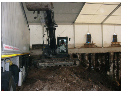
Figura 4: Rimozione di terreno contaminato con autopala a cabina chiusa
