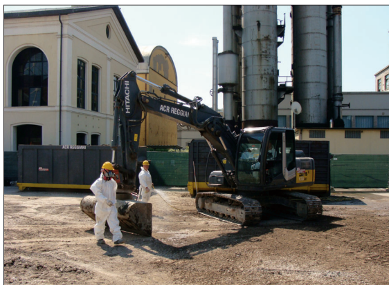
Figura 1: Operazioni pre-scavo terreno contaminato
