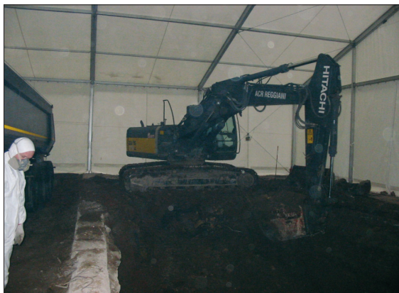
Figura 2: Operazione di scavo terreno contaminato
