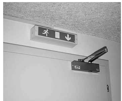
Figura 6: esempio di illuminazione di emergenza.
