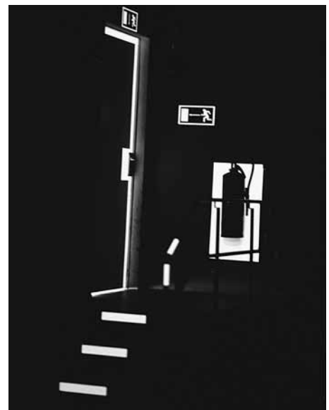
Figura 5: via di fuga segnalata da strisce luminescenti (in condizioni di buio).
