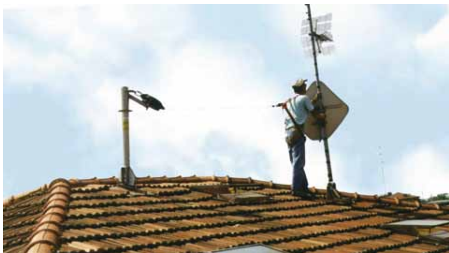
Utilizzo DPI, arresto caduta con punto di ancoraggio puntiforme.
