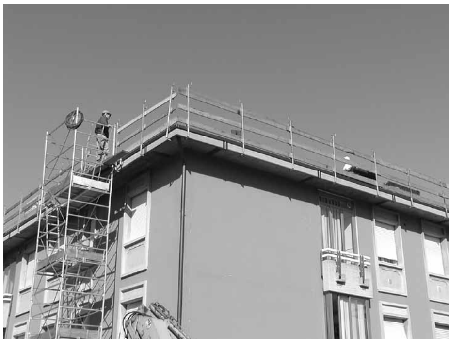
Sistemi provvisori di protezione bordi tetti
